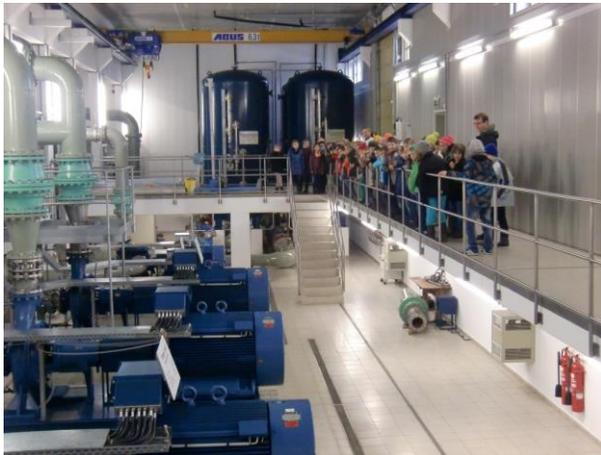
Mit Hilfe von fünf Hochdruckpumpen wird das Wasser schließlich in die Hochbehälter in Neuhoft und Hüttenheim transportiert, von wo aus die verschiedenen Ortschaften mit Trinkwasser versorgt werden.
